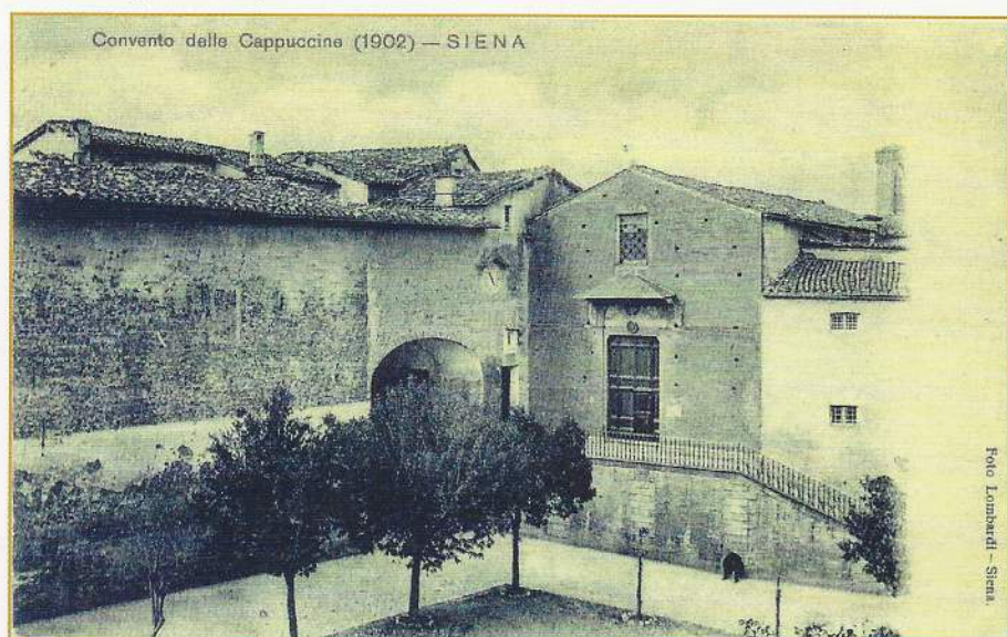
Il Convento delle Cappuccine come appariva prima della demolizione
